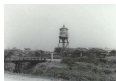
とのもちはいずいとう げんせい かたざりちよう 殿町配水塔(現在の片桐町)
