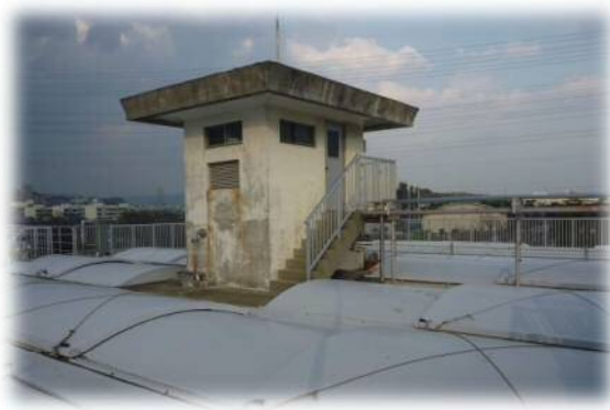
凝集沈殿池（十日市浄水場）
