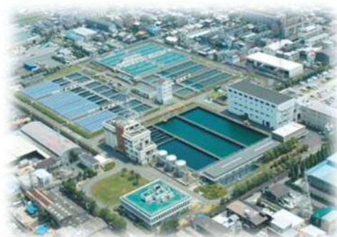
三島浄水場（三島浄水施設）
