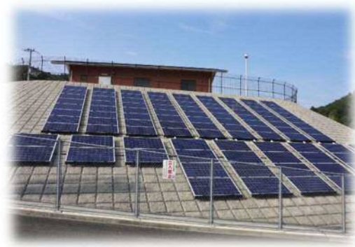
やまぶき高区配水池
