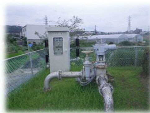
十日市浄水場 第3号取水井
