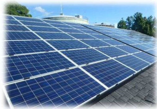
西穂積配水場
