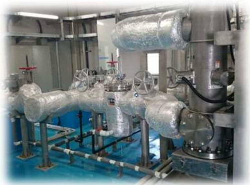
紫外線照射設備（十日市浄水場）
