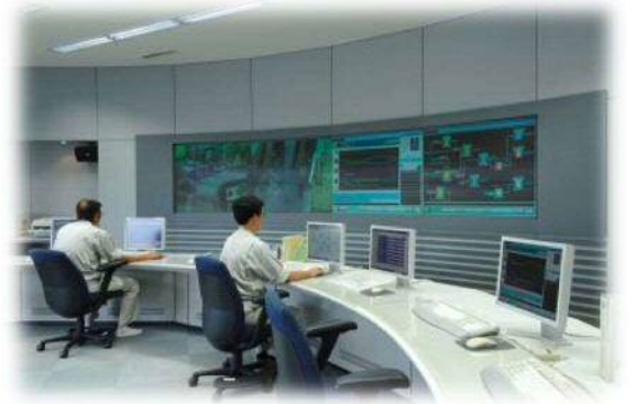
十日市浄水場中央監視室
