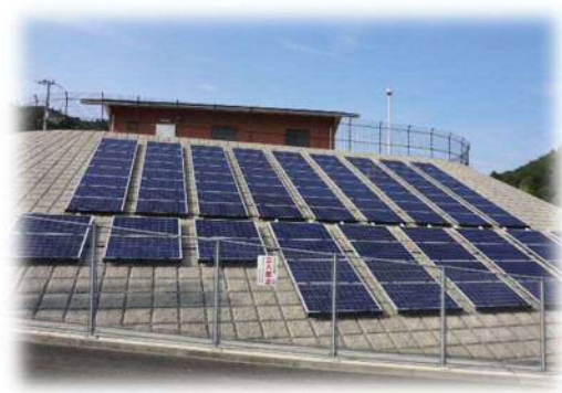
やまぶき高区配水池
