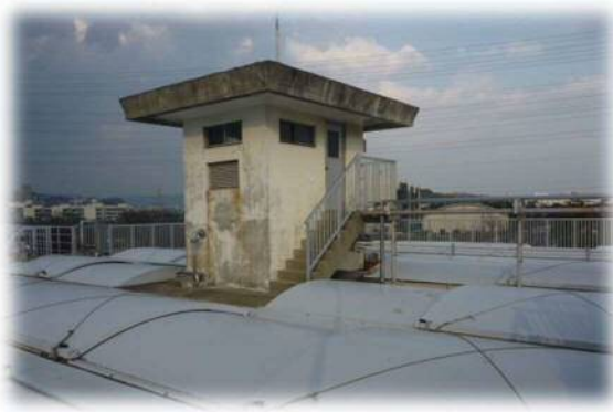
凝集沈でん池（十日市浄水場）
