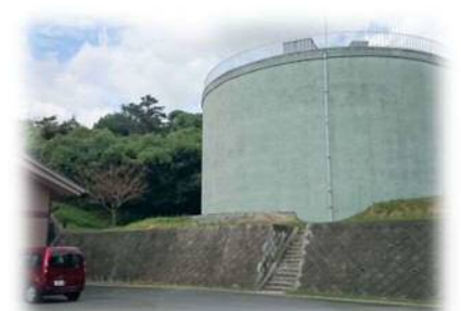
西穂積配水場
