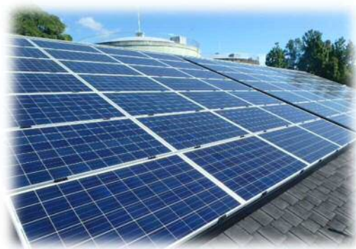
西穂積配水場
