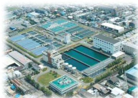
三島浄水場（三島浄水施設）
