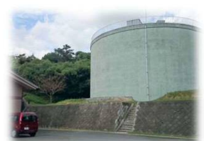
西穂積配水場
