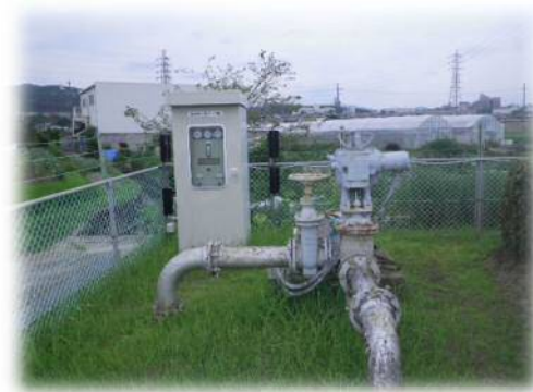
十日市浄水場 第3号取水井
