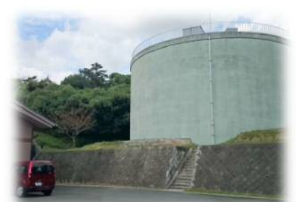
西穂積配水場
