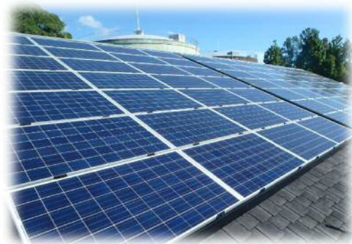
西穂積配水場
