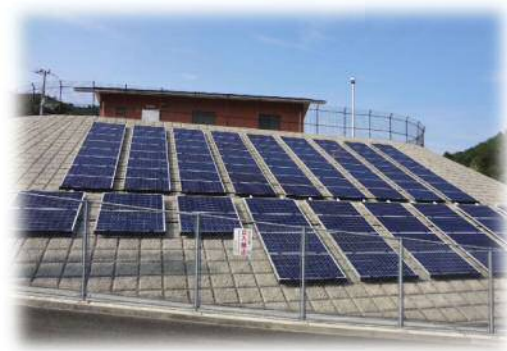
やまぶき高区配水池
