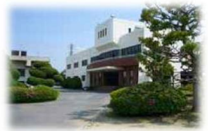
十日市浄水場
