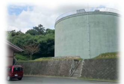
西穂積配水場
