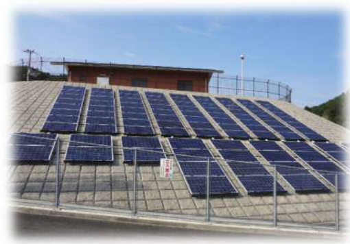
やまぶき高区配水池
