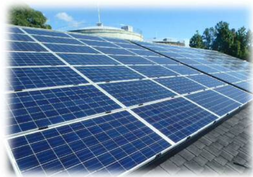
西穂積配水場
