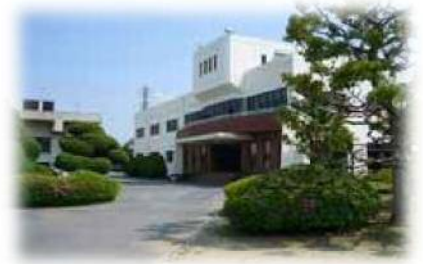
十日市浄水場
