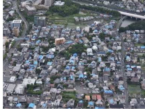
大阪北部地震による被害の様子
