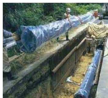
ポリスリーブで保護されたダクティル鑄鉄管 (出典：日本ダクティル鉄管協会)
