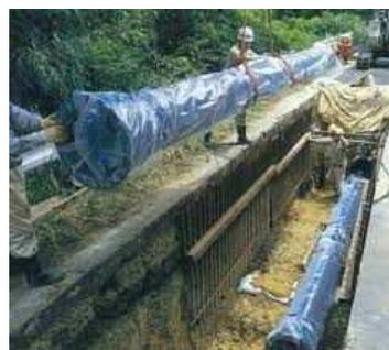
ポリスリーブで保護されたダクティル鑄鉄管
