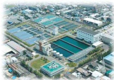
三島浄水場（三島浄水施設）
