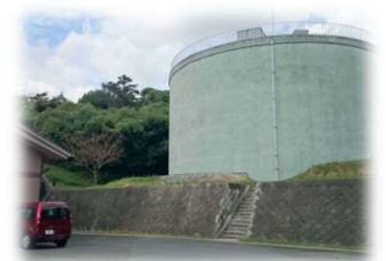
西穂積配水場
