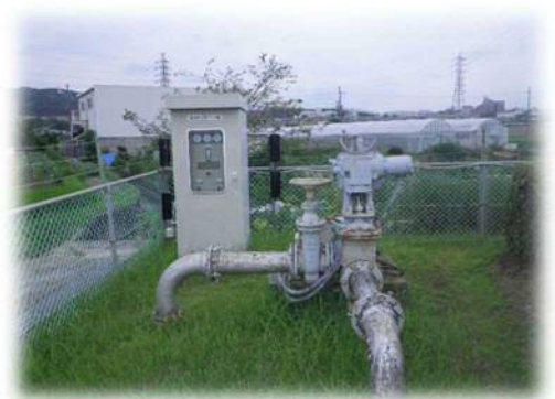
十日市浄水場 第3号取水井
