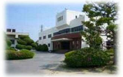
十日市浄水場
