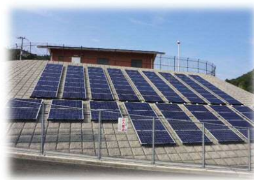
やまぶき高区配水池
