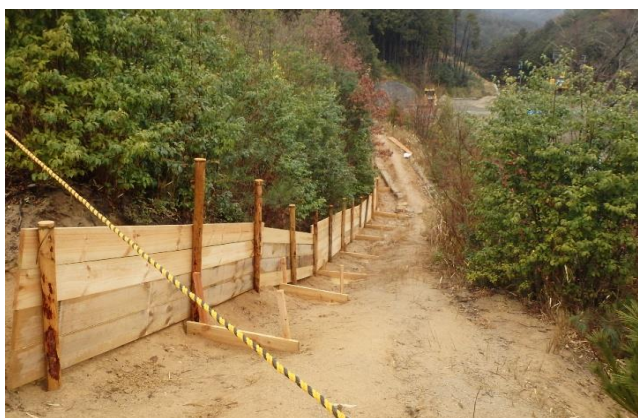
《千提寺菱ヶ谷遺跡土留工事の様子》
