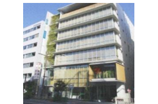
商業施設等の壁面植栽
