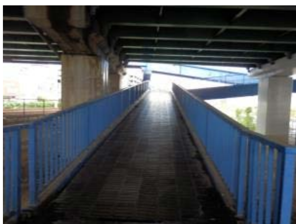
⑦ 下穂積第2歩道橋
