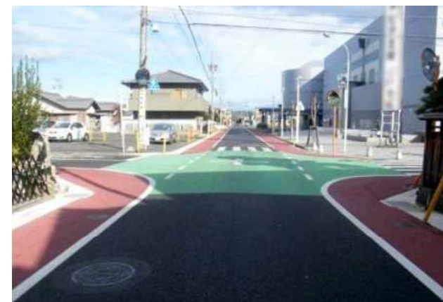
▲路側帯及び交差点のカラー舗装による安全確保事例 (出典:警察庁HP)
