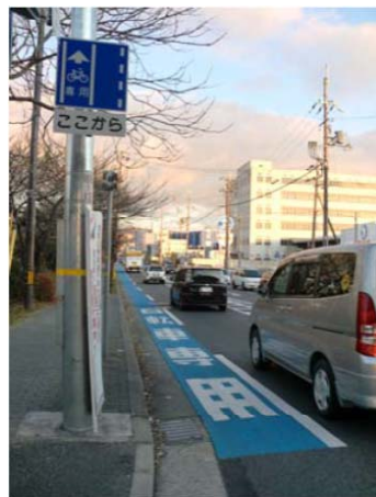
▲自転車利用環境整備例(左:自転車専用通行帯、右:車道混在で通行位置を示した例) (出典:国土交通省、警察庁「安全で快適な自転車利用環境創出ガイドライン」)
