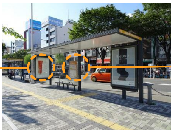
広告付き上屋（堺市：市役所前）
