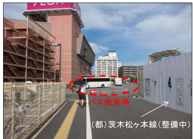
図 （都）茨木松ヶ本線整備により移転等が 必要な JR 茨木駅周辺の送迎バス発着場
