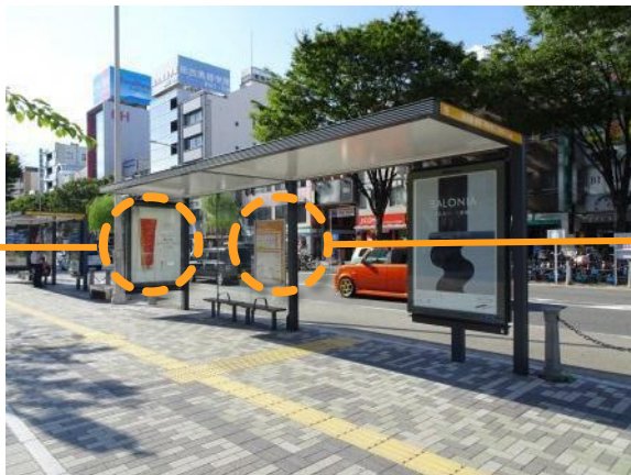
広告付き上屋（堺市：市役所前）
