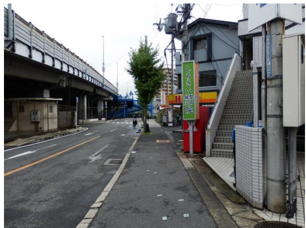
② 大阪中央環状線の現況
