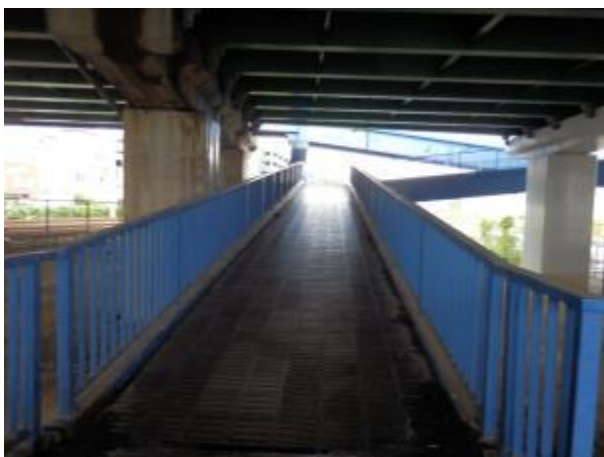
⑦ 下穂積第2歩道橋
