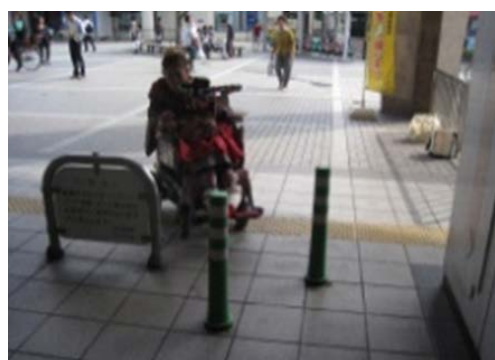
通り抜け通路の車止めが車椅子の通行 を阻害（阪急茨木市駅）
