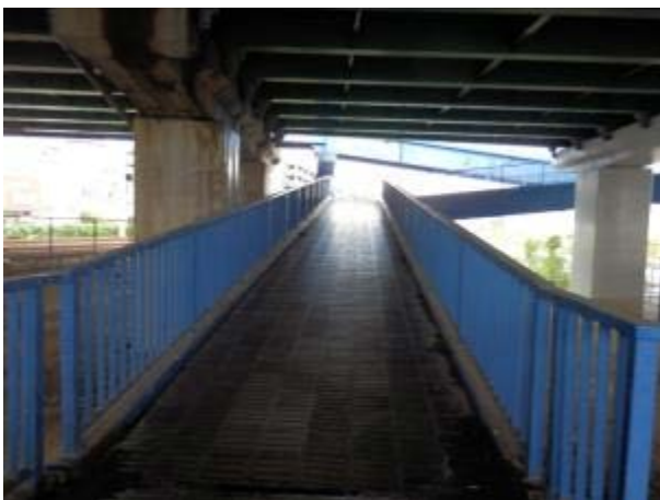
⑦ 下穂積第2歩道橋
