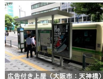
広告付き上屋 (大阪市: 天神橋)
