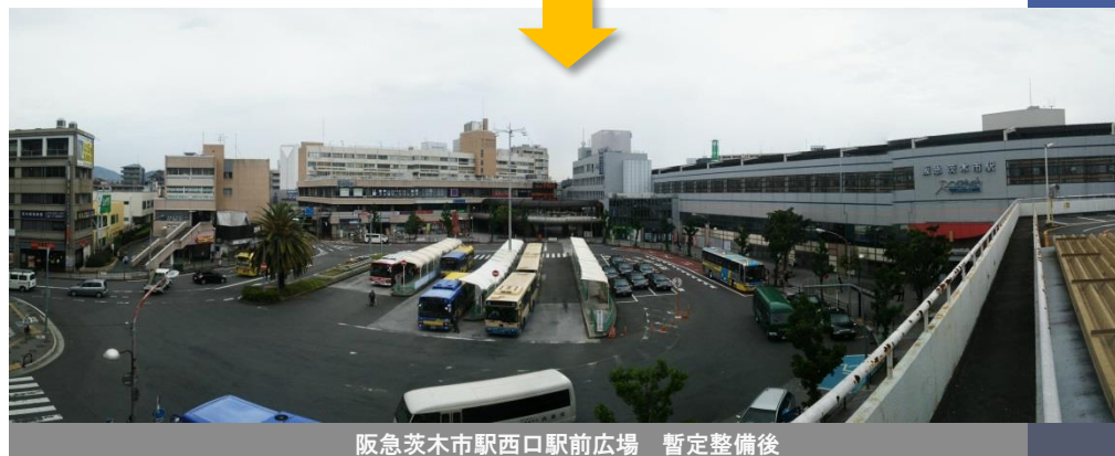
阪急茨木市駅西口駅前広場 暫定整備後
