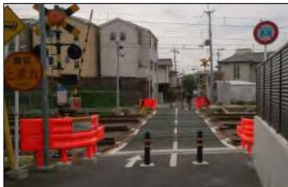
図 踏切の安全対策
