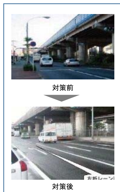
資料：大阪府 HP 図 するっと交差点対策事例 【若草町交差点（茨木市）：左折レーン設置】
