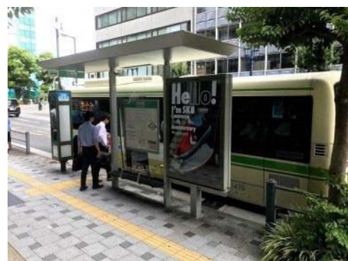
広告付き上屋（大阪市：天神橋）
