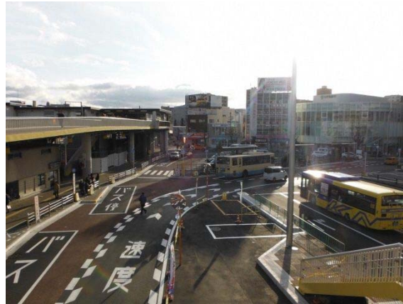
図 JR 茨木駅西口駅前広場 暫定整備状況
