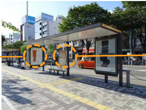
広告付き上屋（堺市：市役所前）
