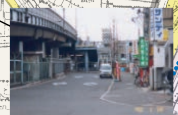
横断歩道の移設・設置の必要性がある。
