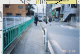
歩道横断勾配がきつい。歩道へ自動車乗り上げている。
