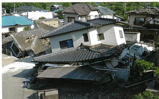
地震による被害例（熊本地震）
