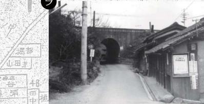
丸また 昭和 44 年頃の国鉄の高架をくぐるトンネル（通称：丸また） 明治 9 年の東海道本線開通と同時に造られ、現在も生活道路として残っている。レンガが斜めに積まれているのが特徴。
