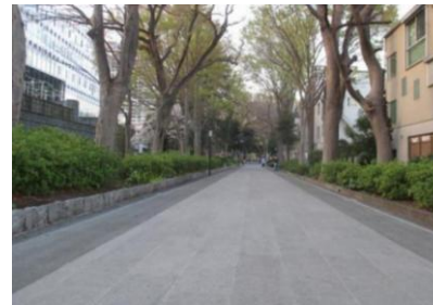
▲周辺の景観と調和し、上質感を演出する舗装色の例 (多様なニーズに応える道路の事例集 (国土交通省))
