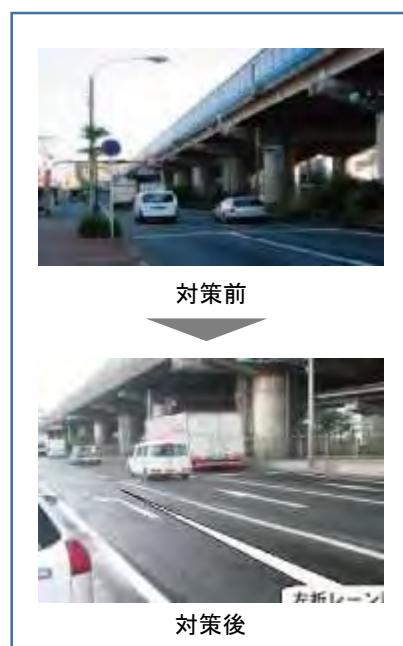
図 するっと交差点対策事例 【若草町交差点（茨木市）：左折レーン設置】
