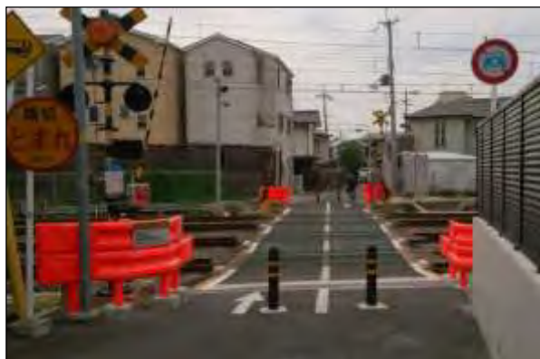
図 踏切の安全対策
