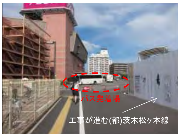
図 （都）茨木松ヶ本線整備により移転等が必要な JR 茨木駅周辺の送迎バス発着場
