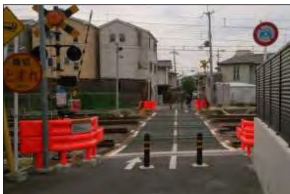
図 踏切の安全対策
