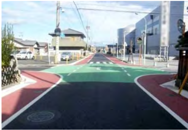
▲路側帯及び交差点のカラー舗装による安全確保事例 (出典:警察庁HP)
