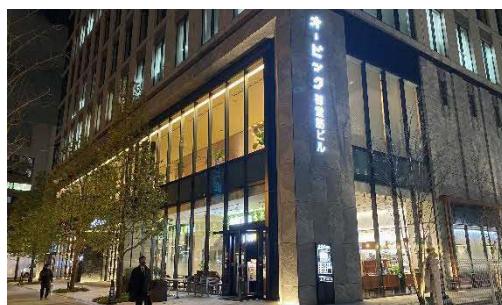
箱文字(内照式)の表面のみを発光させて光の量を抑えている事例
