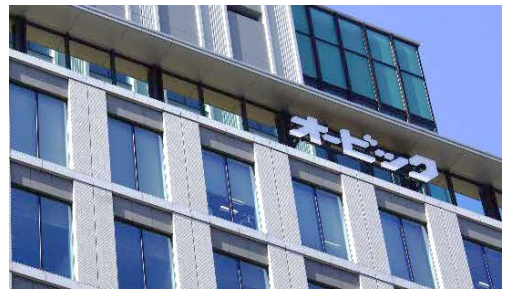
箱文字を用いて、建物と一体的な意匠としている事例
