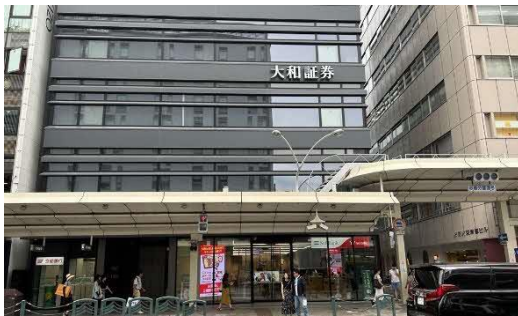
箱文字を使用して、建物外観やまちなみに馴染ませている事例
