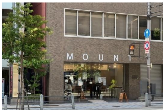
視認性を考慮し、適切な文字の大きさとしている事例(大阪市)
