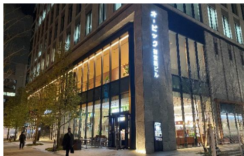
箱文字(内照)を使用し、小さい光源で効果的に掲出している事例(大阪市)
