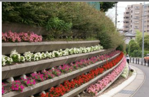
のり面を緑化することで、まちなみにうるおいを創出しています。
