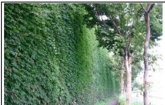
擁壁を蔦などで緑化することで、まちなみにうるおいを創出しています。
