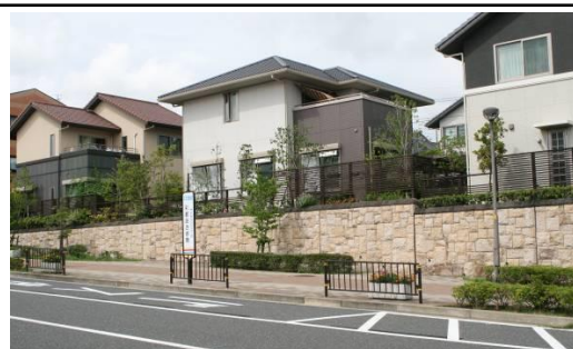
擁壁に化粧を施したり、自然素材を使用したりすることで圧迫感を軽減しています。
