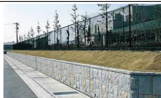
擁壁に化粧を施したり、自然素材を使用したりすることで圧迫感を軽減しています。
