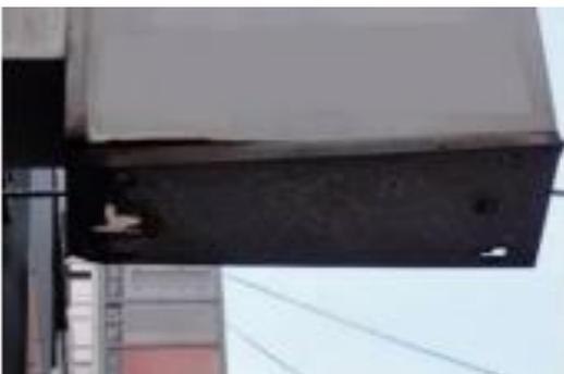
底部の腐食により、側板の破損・落下や表示面板脱落のおそれがあります。
