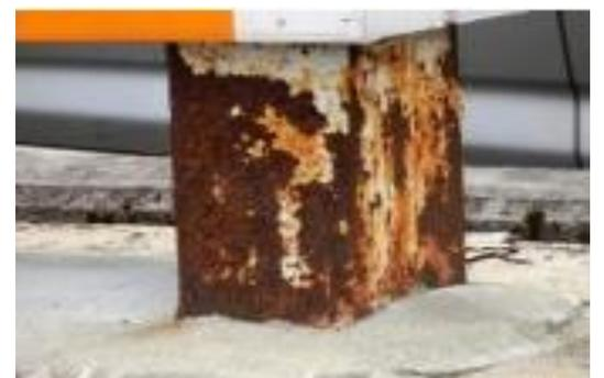
支柱根元の腐食は、支柱根元付近からの転倒の要因となります。
