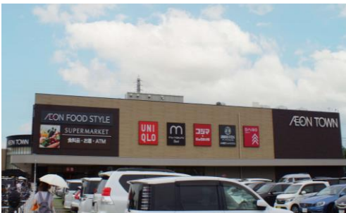
建物と一体的に計画し、大きさを揃えることで整った印象にしている事例
