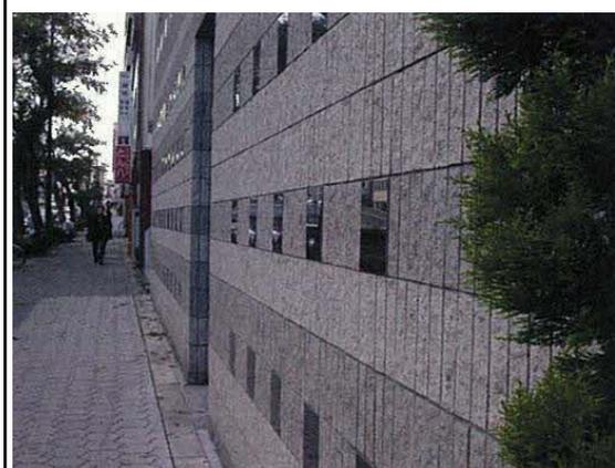
石材風の外壁は汚れが目立ちにくく、時間の経過によって風合いが増しています。
