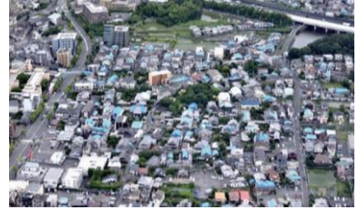
大阪北部地震における被災状況
