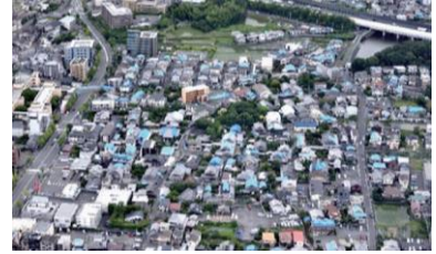
大阪北部地震における被災状況
