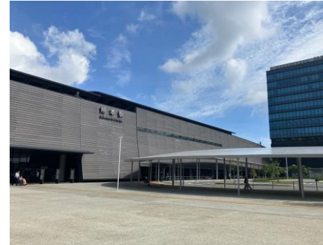
熊本県熊本市：熊本駅東口駅前広場
