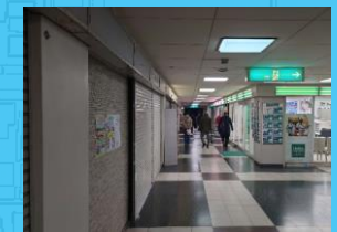
耐震性不足の建物内通路
