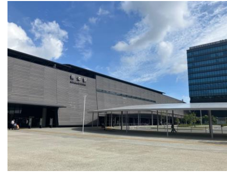
熊本県熊本市：熊本駅東口駅前広場
