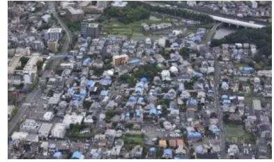
大阪北部地震における被災状況
