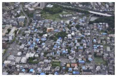
大阪北部地震おける被災状況
