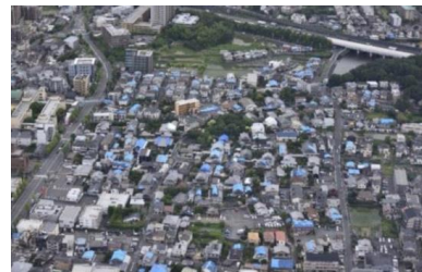
大阪北部地震おける被災状況
