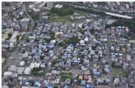
大阪北部地震における被災状況
