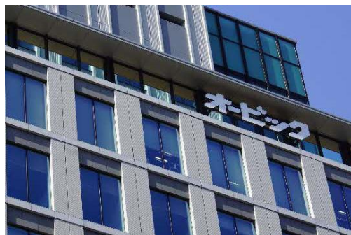
切文字を用いた壁面広告物(大阪市)
