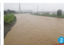
太田橋下流(名神高速直下流)
