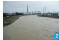
太田橋下流(名神高速直下流)
