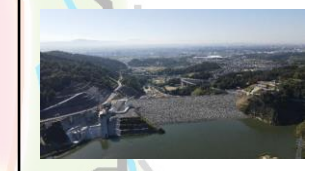
③安威川ダムの整備による治水対策の推進
