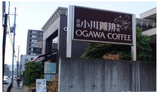
外壁色と合わせた色彩を表示面に使用して、まちなみから突出しない印象としている事例
