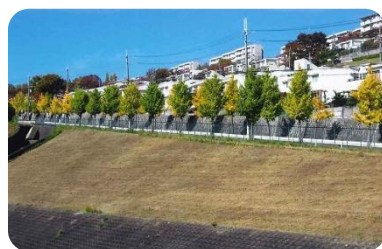
山手台の法面(エッジ)
