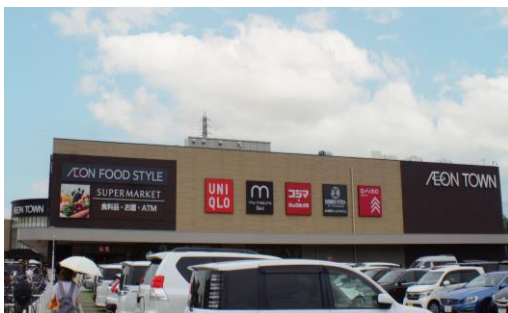
建物と一体的に計画し、大きさを揃えることで整った印象にしている事例
