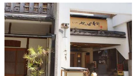
板面に木材を使用して、良好な景観を形成している事例
