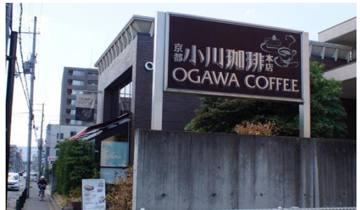
外壁色と合わせた色彩を板面に使用して、まちなみから突出しない印象としている事例
