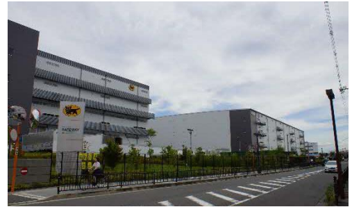
通りの見通しを妨げないように、大きさや高さを抑えて配置している事例
